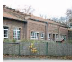
Gasversorgungs- zentrum Ost, Karlsruhe Deutschland
