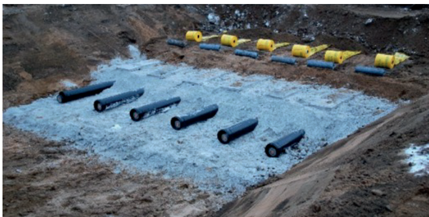
Abbildung 20: Wärmeleitfähiges Bettungsmaterial in einer Trasse der Amprion GmbH [49]
