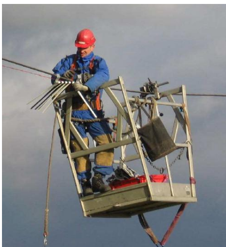
Bild 2: Montage mit dem Leitungsfahrwagen (links) und mit dem Leitungsfahrrad (rechts)
