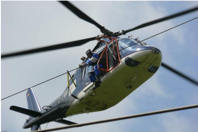
Bild 4: Montage der Vogelschutzmarkierung mit dem Hubschrauber
