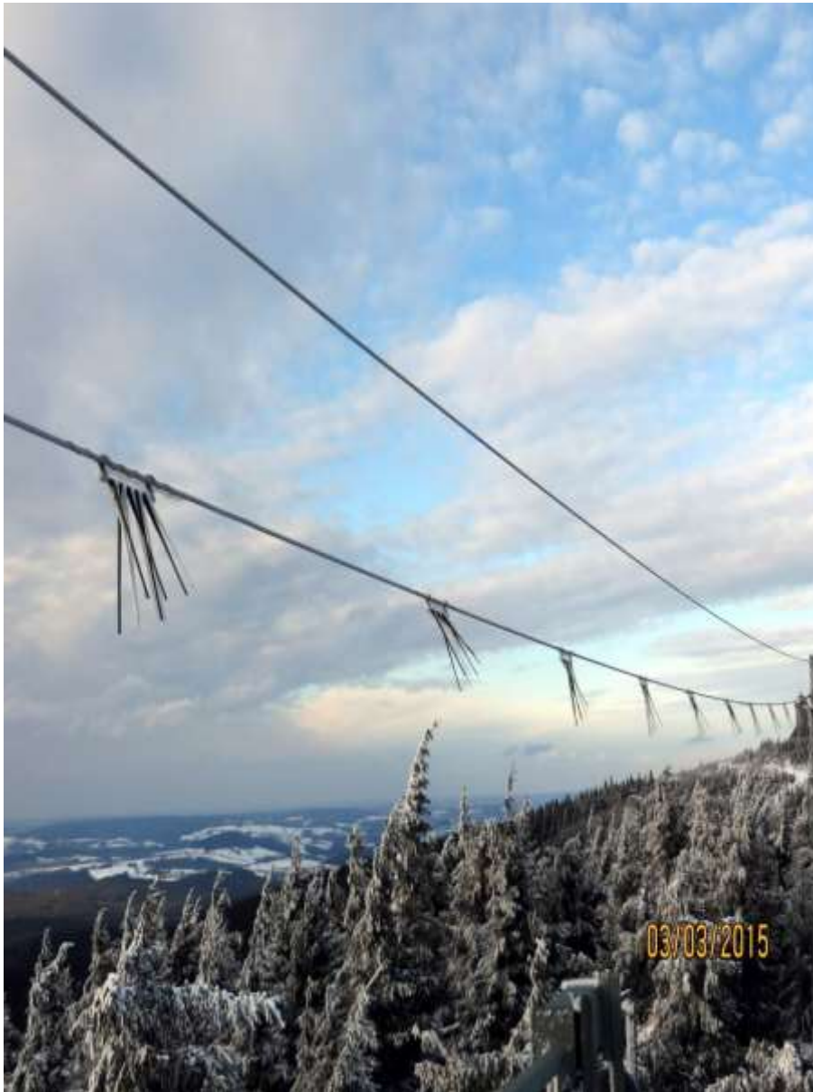
Bild 1: Leiter ohne und mit Vogelschutzarmaturen.
