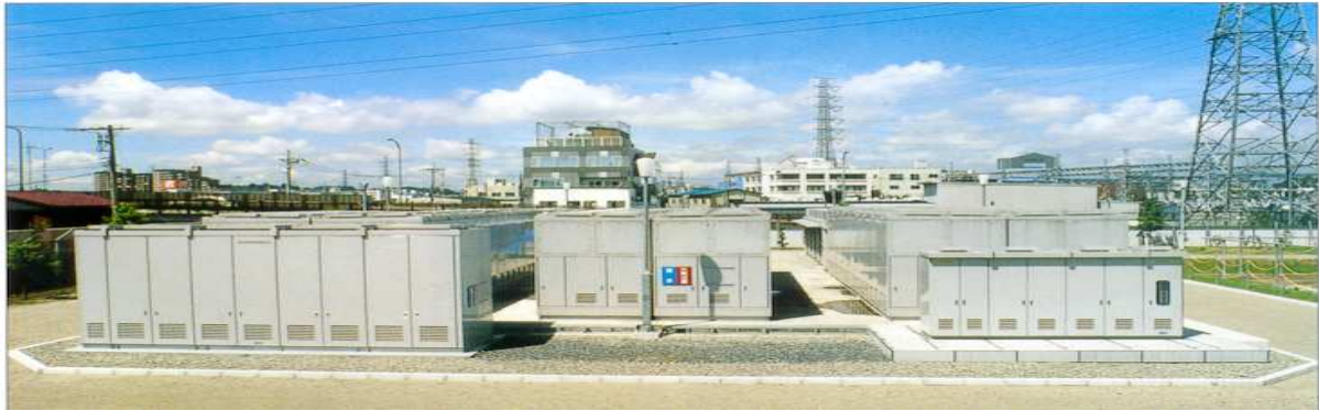
Abbildung 39: Natrium-Schwefel-Hochtemperaturbatterie für den Load-Levelling-Betrieb (Tokyo Electric Power Company, Tsunashima – 6 MW, 48 MWh)
